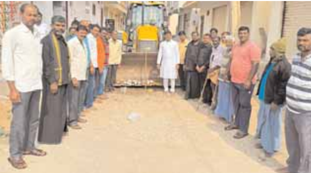
అండర్ డ్రైనేజీ పనులను ప్రారంభించిన మధు మోహన్
