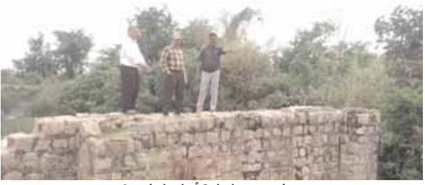
ప్రాజెక్టును పరిశీలిస్తున్న అధికారులు. ధారూర్, మేజర్ న్యూస్ (జూన్ 20): మండల పరిధిలోని కోట్ పల్లి ప్రాజెక్టును గురువారం ఇంజనీరింగ్ చీఫ్ అనిల్ కుమార్ పరిశీలించారు.కోట్ పల్లి ప్రాజెక్టు
