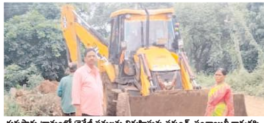
ఈర్లపాడు గ్రామంలో డ్రైనేజీ పనులు నిర్వహిస్తున్న సర్పంచ్, పంచాయతీ కార్యదర్శి
