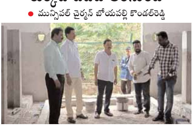
నిర్మాణ పనులను పరిశీలిస్తున్న చైర్మన్ కొండలరెడ్డి
