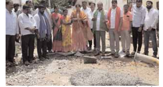
బాలాపూర్ మేజర్ న్యూస్ (ఆగస్టు 27): 17వ డివిజన్ పాత గ్రామంలో సీసీ రోడ్డు నిర్మాణాలను కార్పొరేషన్ మేయర్ బిగురింత పారిజాత నర్సింహారెడ్డి ప్రారంభించారు. ఈ కార్యక్రమంలో ప్లొర్ లీడర్ వంగీటి ప్రభాకర్ రెడ్డి కార్పొరేటర్లు పెద్దబావి సుదర్శన్ రెడ్డి, ఏ ఈ ఈ సాయిరాం, నాయకులు రాజ్ గూడెం శ్రీనివాసరెడ్డి, కొలన్ కృష్ణారెడ్డి, బాలింగని జంగయ్య, తుళ్ళ నరహరి గౌడ్, సుధాకర్ రెడ్డి, ఇక్యే శ్రీనివాస్, సుధాకర్, మహిళలు కాలనీవాసులు పాల్గొన్నారు.
