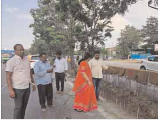
కర్నూల్ ఘాట్ ,మేజర్ న్యూస్ :డివైడర్ నిర్మాణంలో నాణ్యత ప్రమాణాలు పాటిస్తూ ప్రజలకు ఎలాంటి ఇబ్బందులు కలగకుండా , ట్రాఫిక్ సమస్య రాకుండా పనులు చేపట్టాలన్నారు .సాగర్ రింగ్
