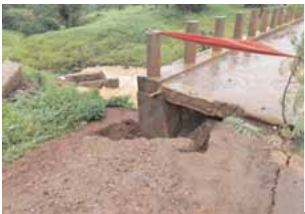
నవాబ్ పేట్ గేట్ వసంపల్లి డెగ్గర సూతనంగా నిర్మించిన బ్రిడ్జి దగ్గర భారీ వర్షానికి కొట్టుకపోయి న మట్టి.
