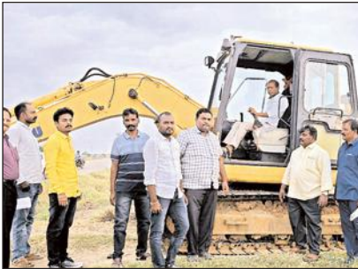
రోడ్డు మధ్యలో పి.వి.జె.ఎస్.వై పథకం కింద మంజూరైన రూ.5.5కోట్లతో నిర్మాణం చేస్తున్న
