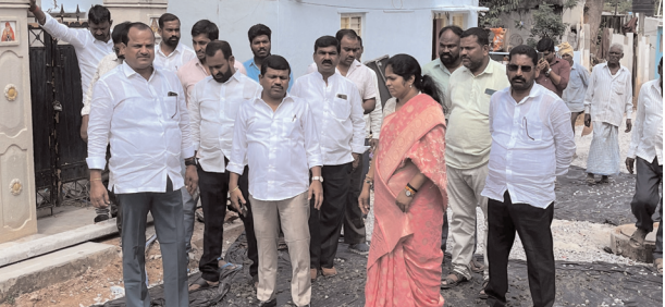
బాలాపూర్ పాత గ్రామంలో సీసీ రోడ్ నిర్మాణ పనులు.
