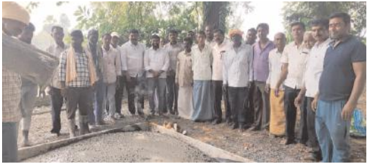
సీసీ రోడ్డు పనులు ప్రారంభించిన
