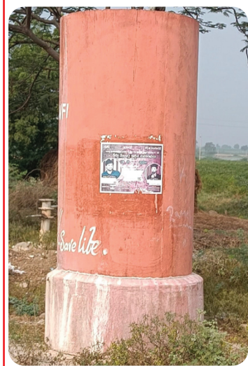
పని చేయని వాటర్ ట్యాంకు దృశ్యం
