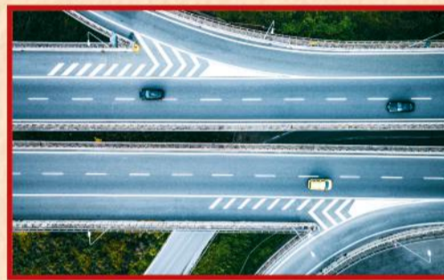
రోడ్ల నిర్మాణం/విస్తరణ (10 ప్రాజెక్టులు) రూ. 4,593 కోట్లు
