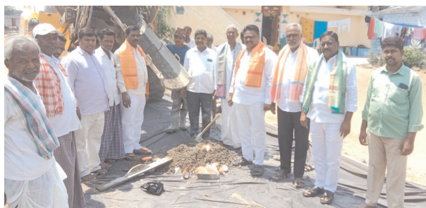
సీసీ రోడ్డు పనులను ప్రారంభిస్తున్న పీవీసీఎస్ చైర్మన్, కాంగ్రెస్ నాయకులు క్రమంలో మార్కెట్ కమిటీ మాజీ చైర్మన్ వెంకట్రాములుగౌడ్, సీనియర్ నాయకులు రాంచంద్రారెడ్డి, మహిపాల్, మొగులయ్య తదితరులు పాల్గొన్నారు.
