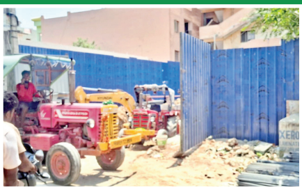
కమలనగర్.. జొన్న ఐరన్ మార్ట్ పక్కన, భారీ అనధికారిక సెల్లార్ నిర్మాణ పనులు జోరుగా...
